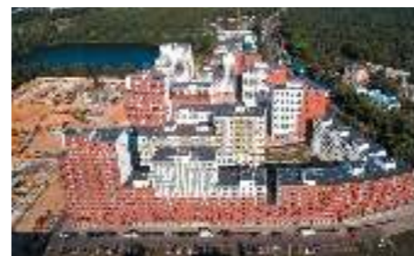
ЖК «Новокрасово», МО «Тройка РЭД»
